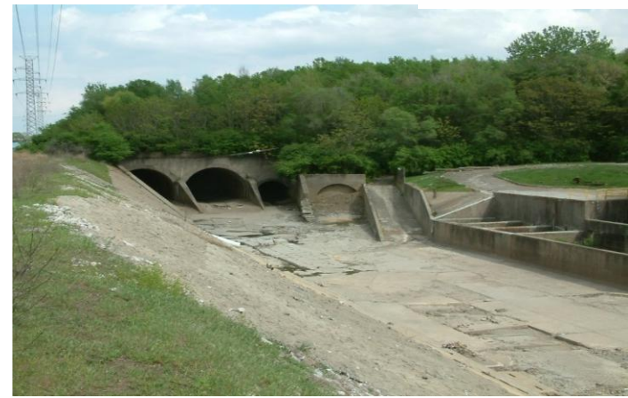
River des Peres CSO Outfall.
